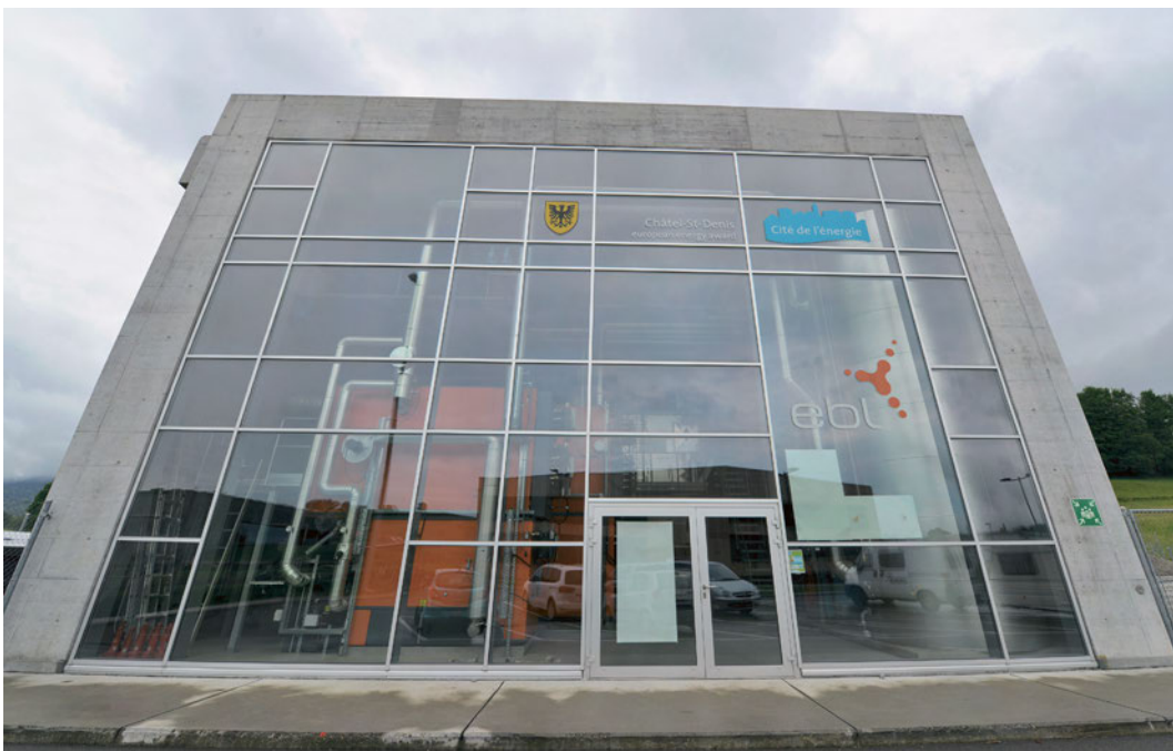
Le volume de béton et de verre laisse à entrevoir les tuyaux inox et les chaudières orange qui y sont logés.
