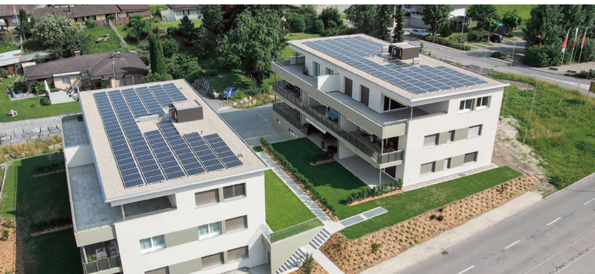
Installations photovoltaïques sur les immeubles de Ponyweid.
