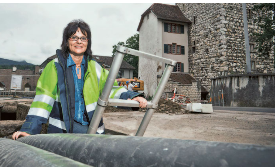
L'ingénieure de projet Corinna Hunziker surveille le chantier du réseau d'énergie à distance: les conduites pour la chaleur et le froid à distance doivent être parallèles.
