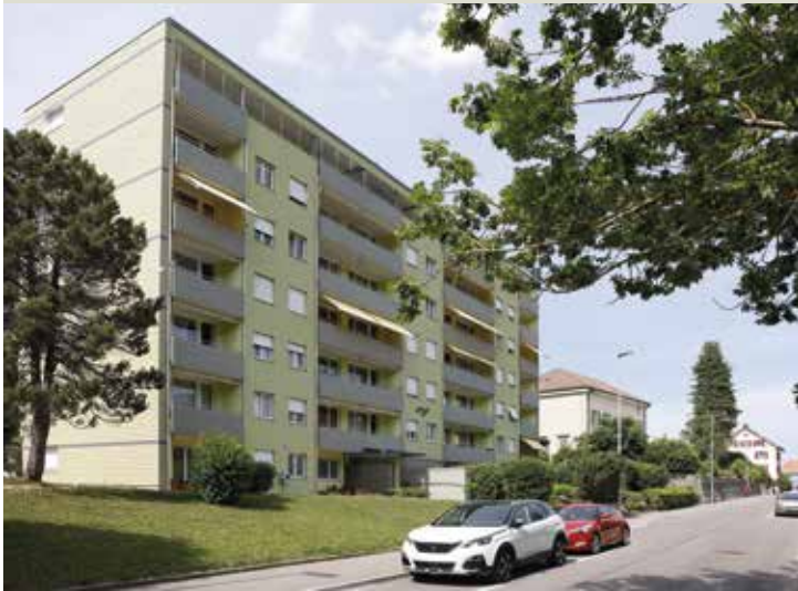
Die Sanierung erfolgte über Jahre in zwei Etappen.
