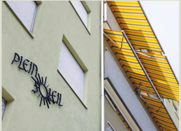
Das Gebäude erstrahlt in neuem Glanz.
