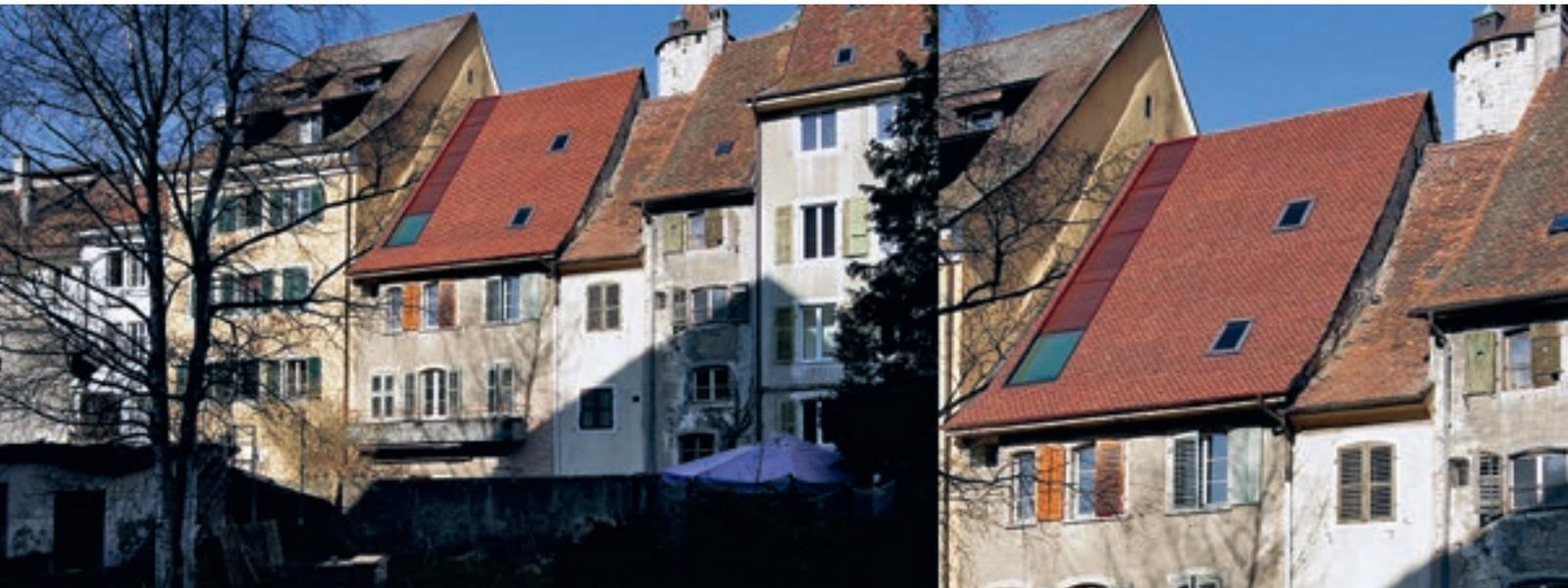
*Une bande de lumière a été créée sur chaque pan de toit de cet immeuble ancien à Porrentruy, afin d'y apporter de la lumière. La partie haute de la bande est couverte d'un treillis métallique de couleur rouille qui se confond avec le reste du toit.*
