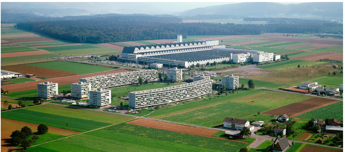
Die Wohnsiedlung Wyde und das Fabrikareal der damaligen BBC im Jahr 1969.
